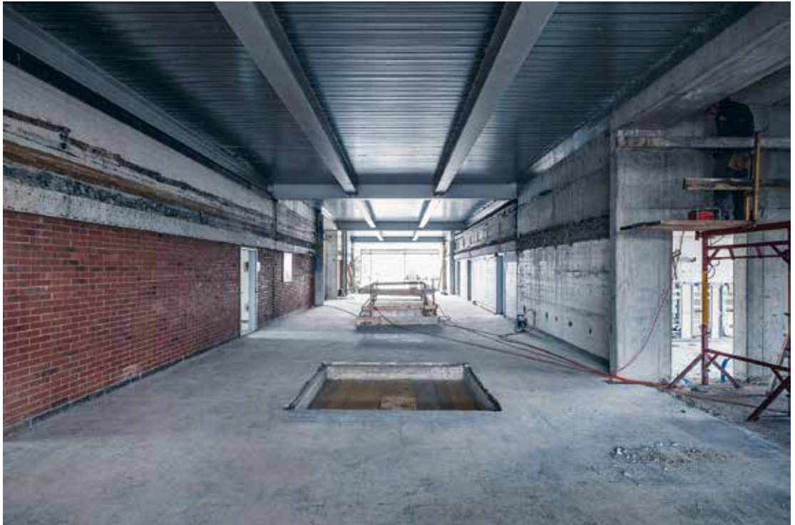
Rost zur Lastverteilung der Aufstockung in Holzbauweise Steel grid for distributing the loads of the added storeys in timber construction
