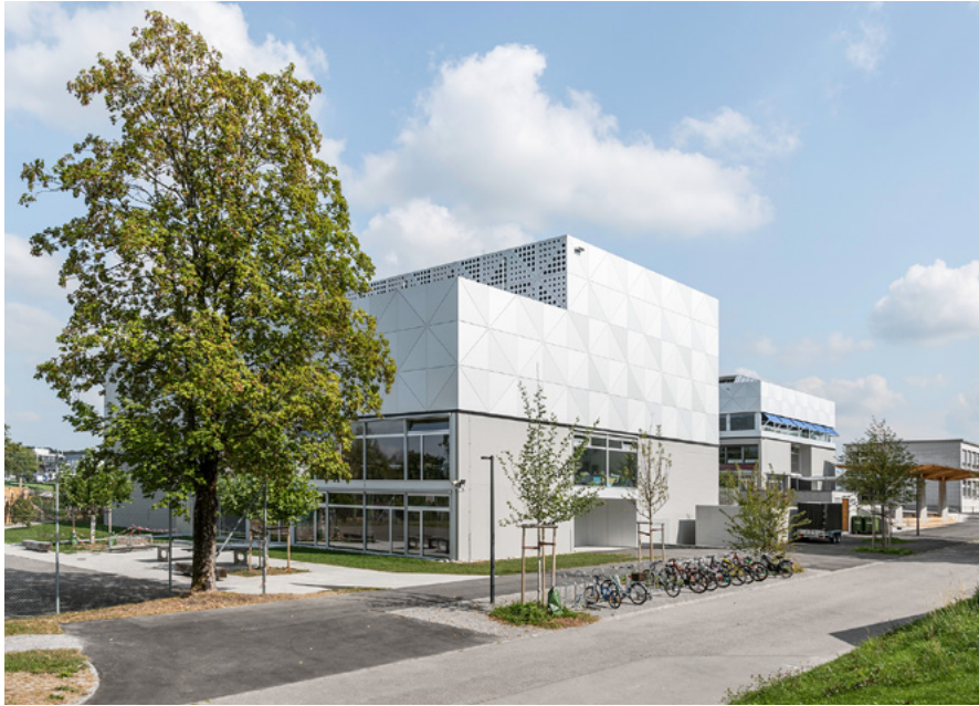
Der gewachsene Raumbedarf der Schule kam in leichten Aufstockungen unter. Im Vordergrund alte und neue Turnhalle. Bilder: Beat Bühler / Bestand: Architekten
