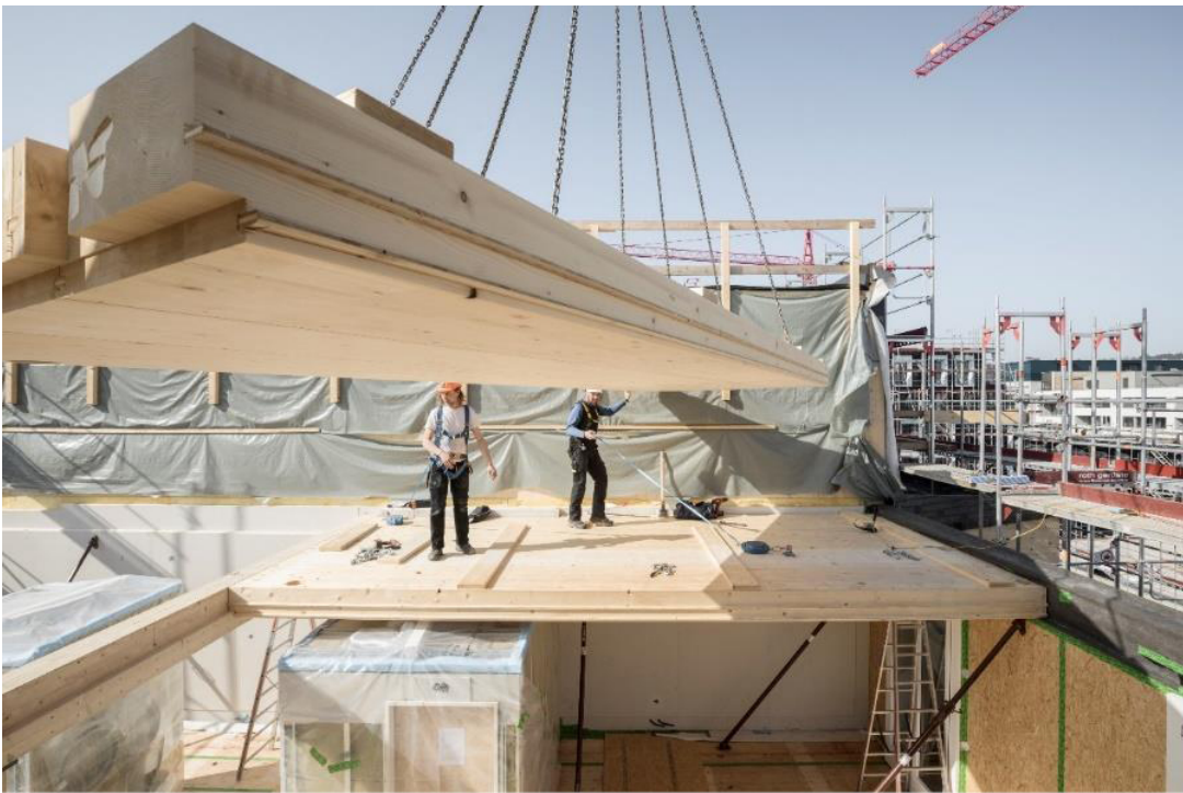
Bild 5 Neustadt aus Holz sue&stil in Winterthur – Planen und Bauen mit nachwachsendem Baumaterial Quelle: weberbrunner architekten/soppelsa architekten, Fotograf Beat Bühler
