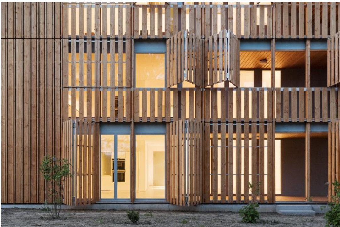
Bild 2 Mehrfamilienhaus Im Amt, Gütenwil – Verwendung nachwachsender Rohstoffe auch in der Fassade Quelle: weberbrunner architekten, Fotograf Beat Bühler
