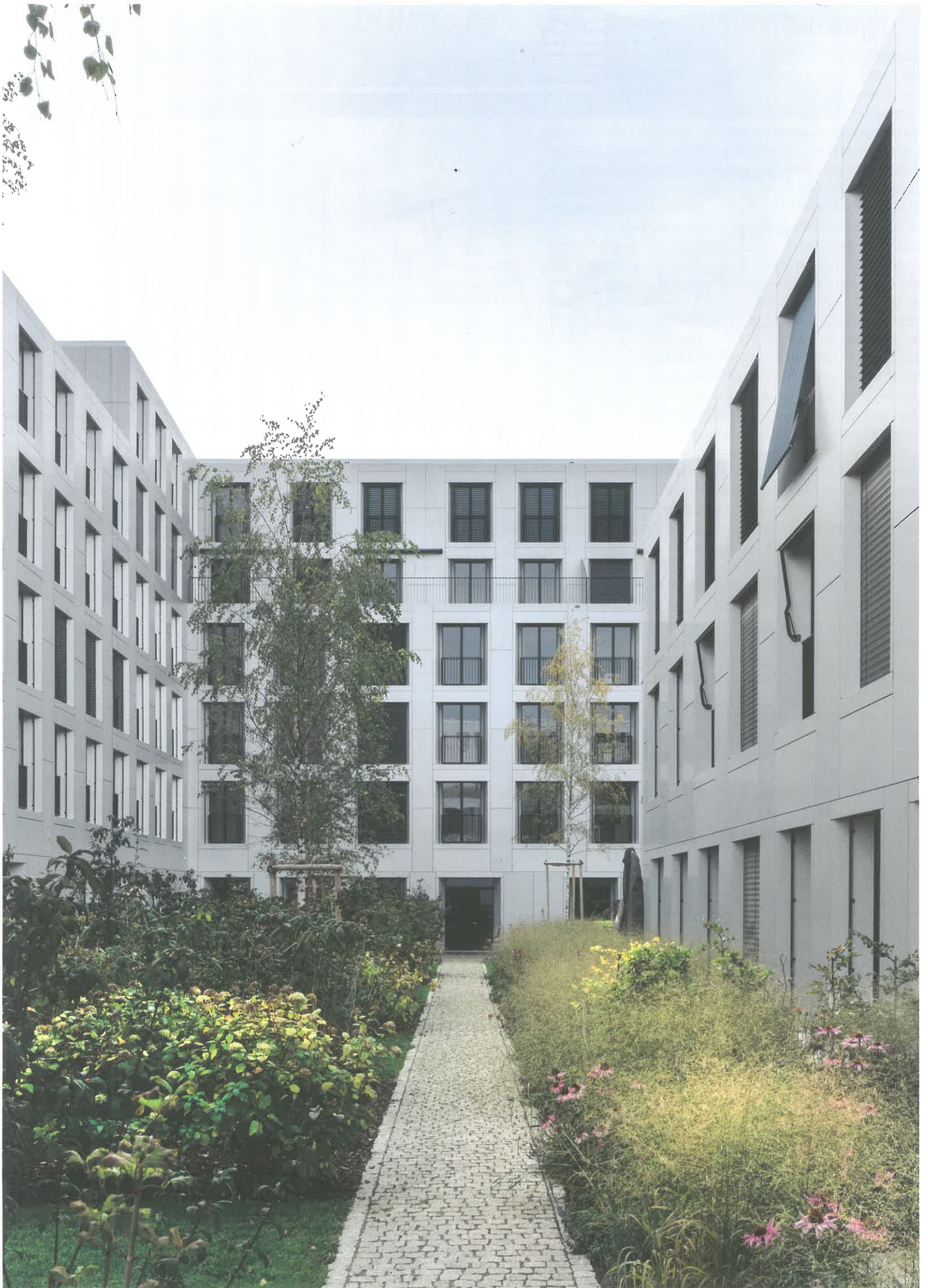
Die dichte Bepflanzung im Innenhof trennt das öffentliche Wegnetz und die privaten Aussenräume.
