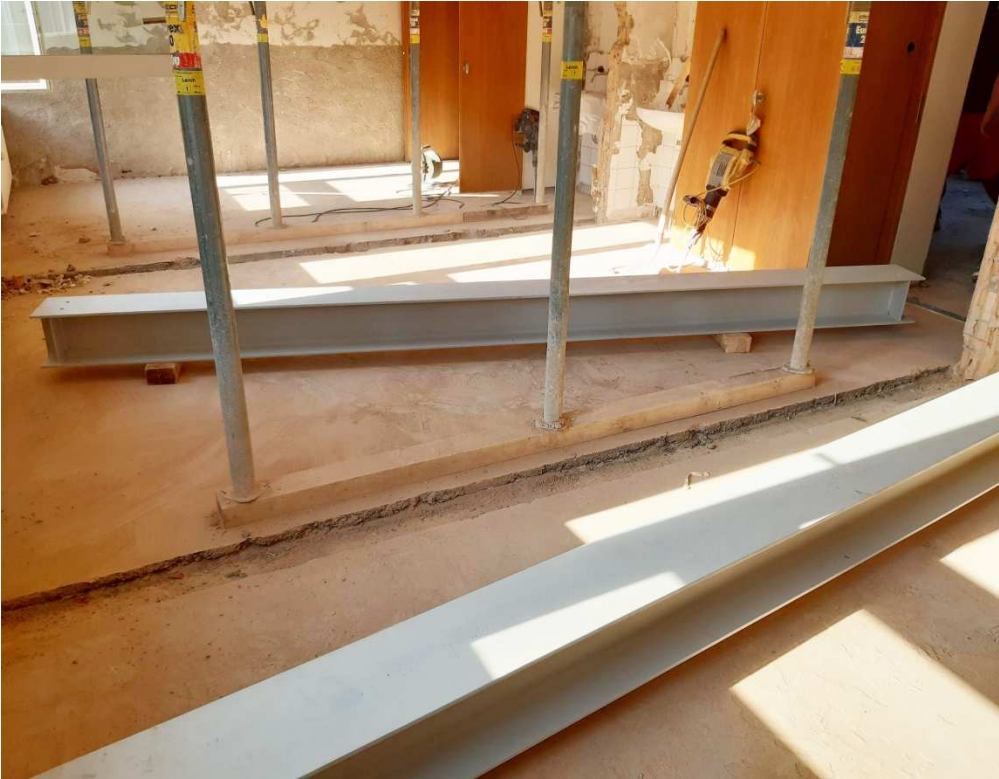
Selektiver Abbruch, Quelle: Kinder- und Jugendpsychiatrie, weberbrunner architekten zürich & berlin
