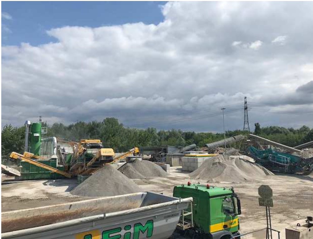
Aufbereitung von Recyclingbeton, Quelle: SenUMVK
